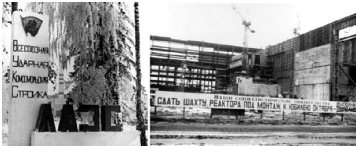
Ленинградская АЭС – ударная комсомольская стройка, 1971 г.
