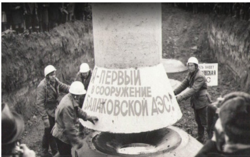
Торжественная закладка Балаковской АЭС, 1977 г.
