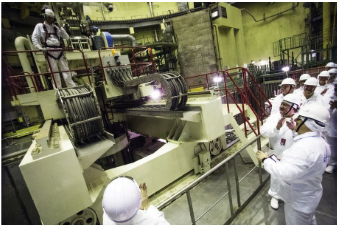
Физический пуск энергоблока № 1 Ленинградской АЭС-2, 2018 г.
