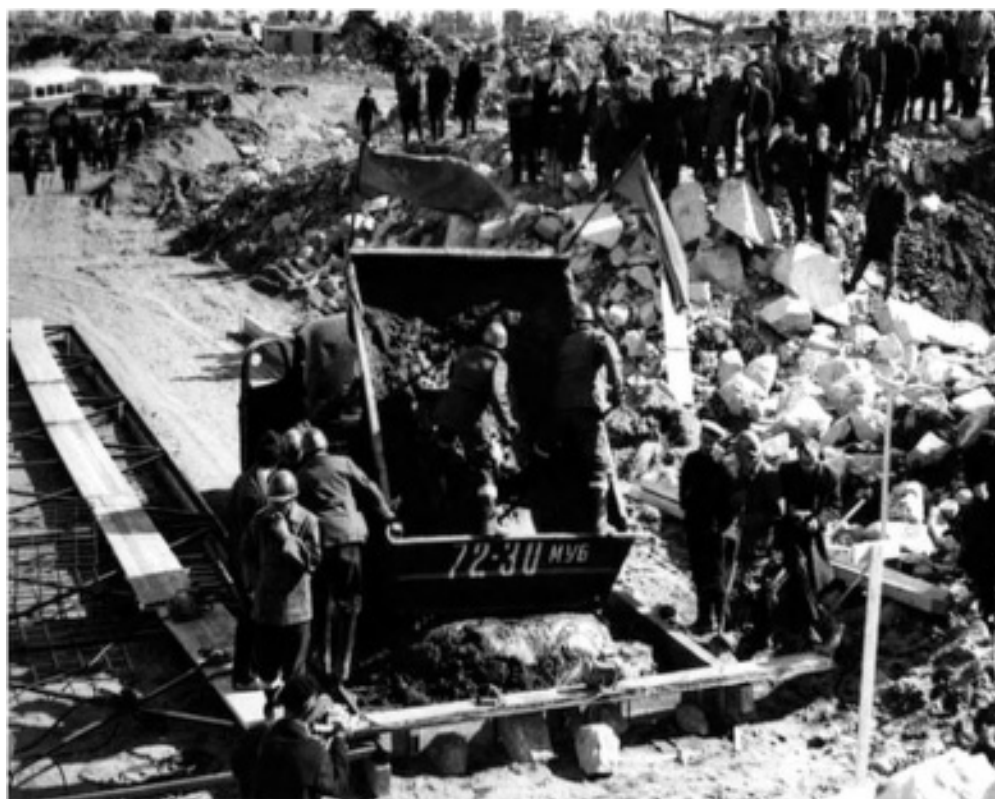
Укладка первого кубометра бетона в основание будущей Кольской АЭС, 1969 г.
