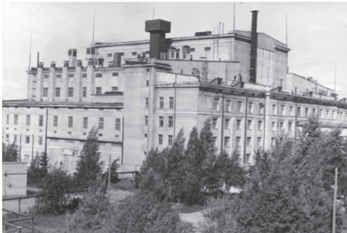
Цех № 1 с установкой СУ-20
