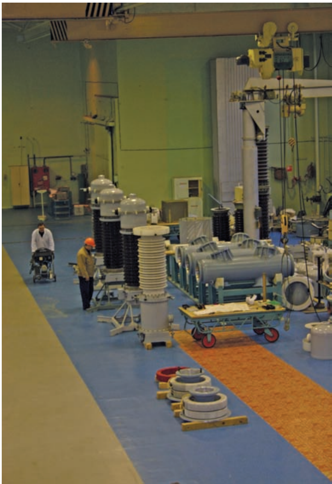
Элегазовое оборудование в пролете цеха
