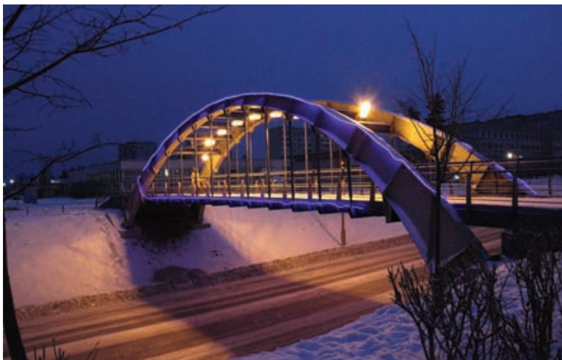
Пешеходный мост через ул. Ленина
