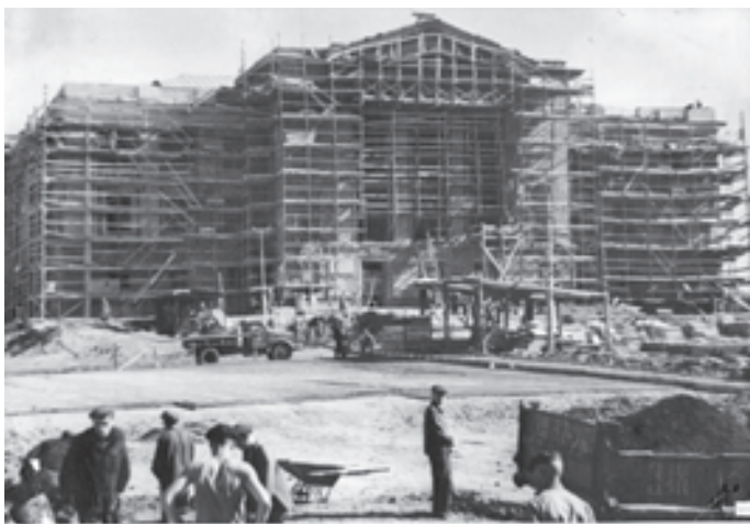
Строительство дома культуры
