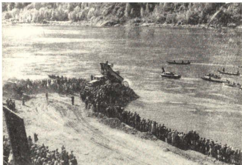
Первая камера в строительстве Саяно-Шушенской ГЭС.
