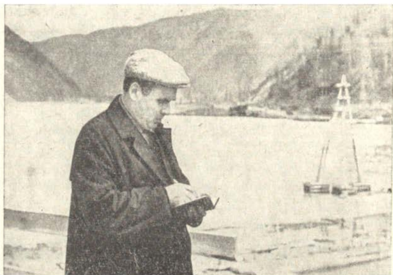
Начальник строительства Сайно-Шушенской ГЭС А. Н. Карякин на месте работ.
