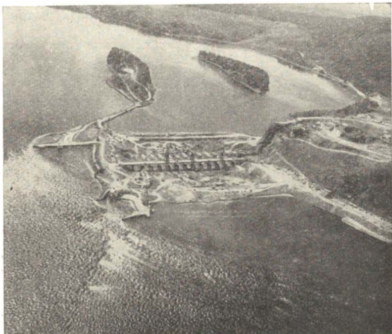
Котлован первой очереди строительства Усть-Илимской ГЭС.
