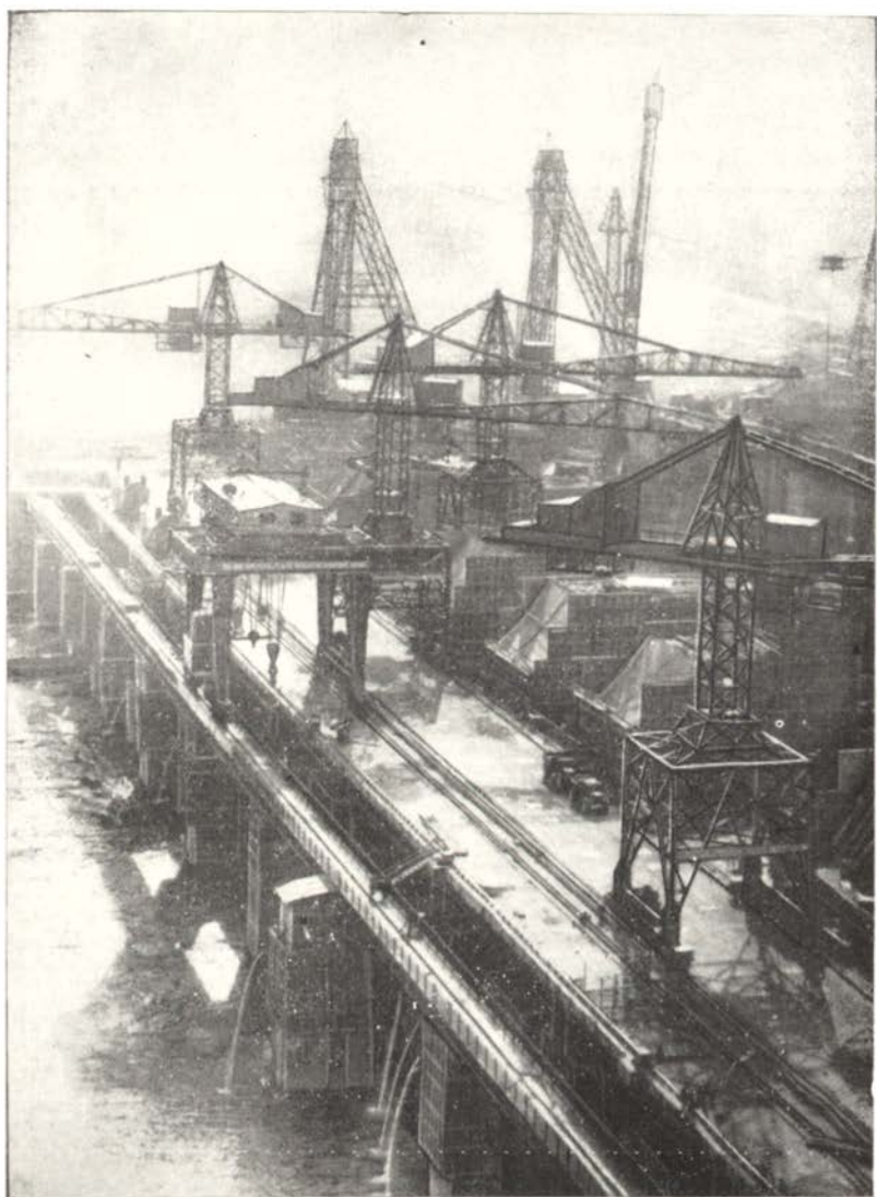
Строительство Красноярской ГЭС.
