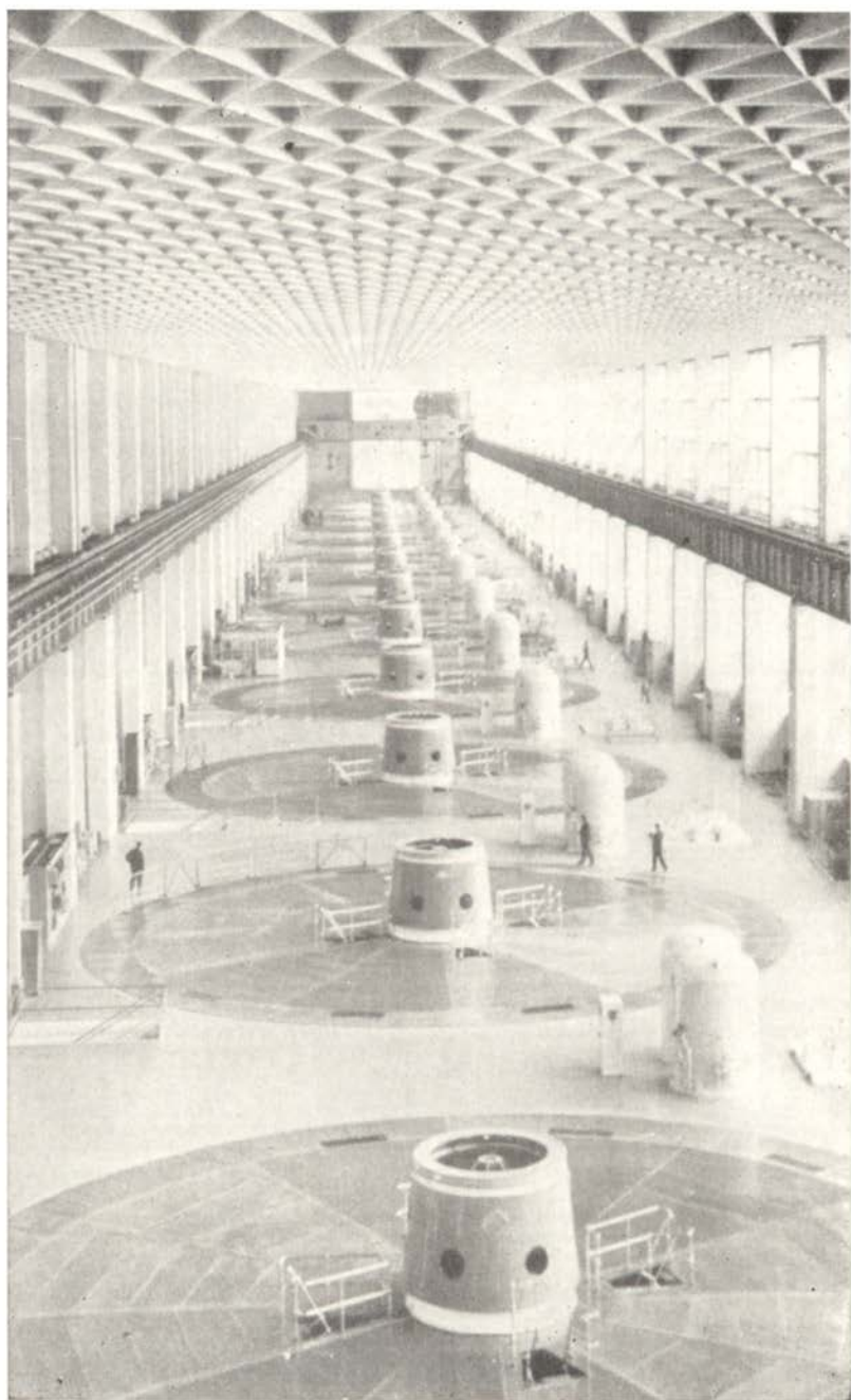
Машинный зал Красноярской ГЭС.
