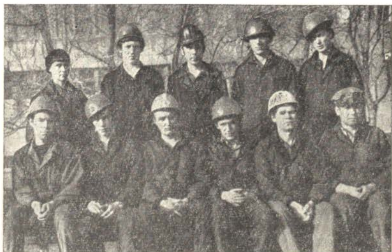
Бригада по ремонту оборудования Беловской ГРЭС. Бригадир Е. И. Понов.
