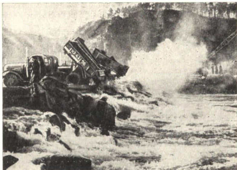
Зимнее перекрытие Ангары в районе Братска. 1957 г.
