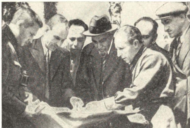
Академик А. В. Виштер (в центре) с группой инженеров-испытателей на месте строительства Иркутской ГЭС.
