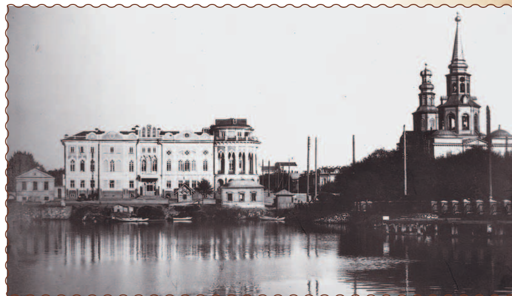
Вид на здание Окружного суда и Екатерининский собор. ГАСО
