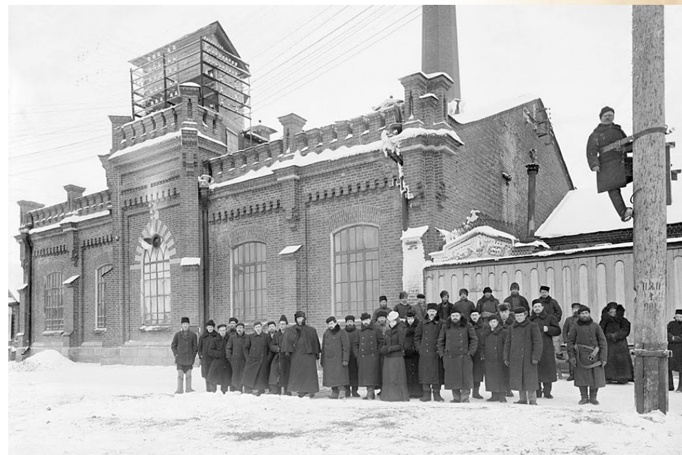
Электростанция . Фото. ГАСО
