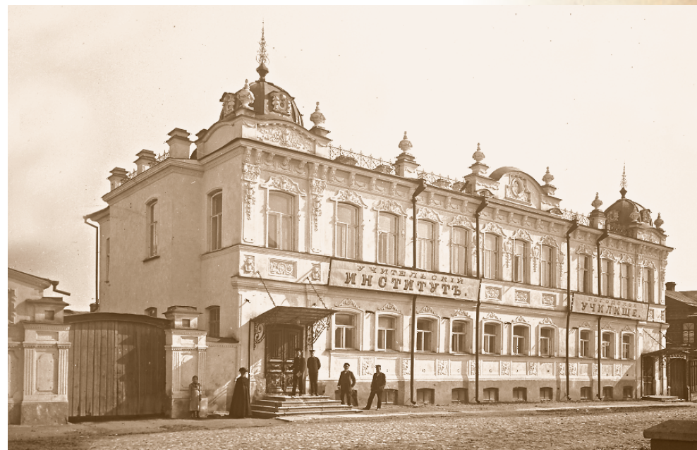
Здание Учительского института. Почтовый пер. Фото. ГАСО
