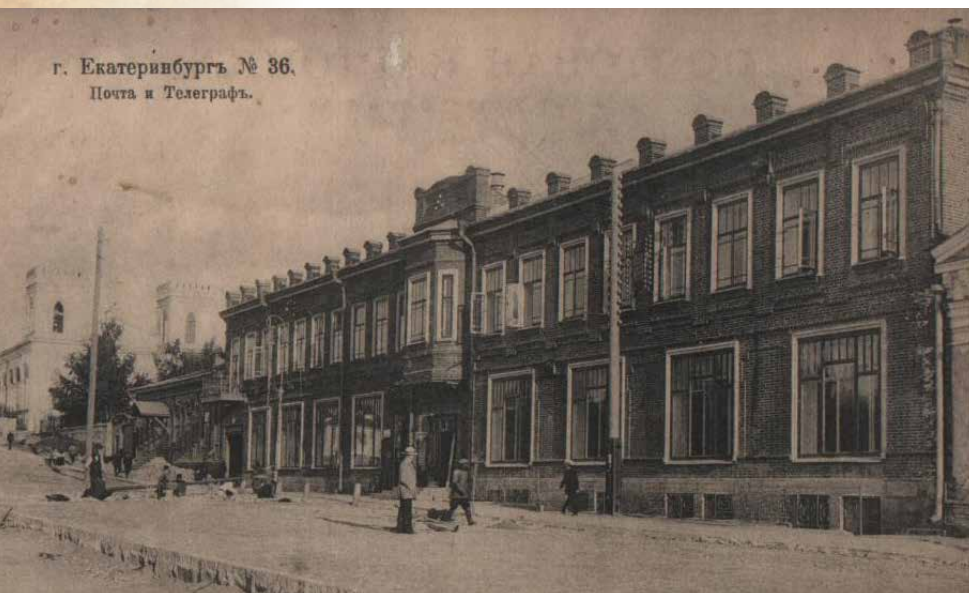
Здание почты. Главный пр-т. Открытка. ГАСО
