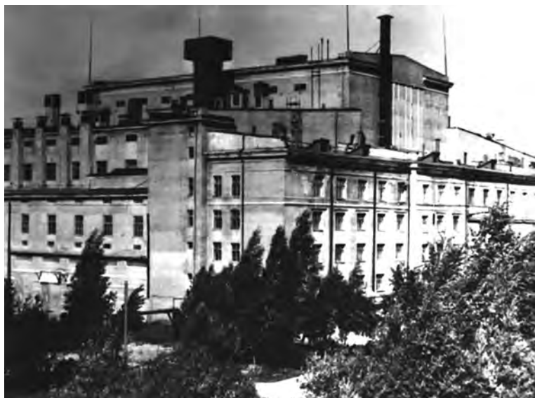
Здание цеха № 1 с установкой СУ-20.
