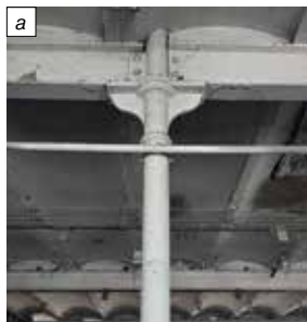
Иллюстрация 6. Схожий подход к перекрытию потолка в больших помещениях, продиктованный соображениями экономии: а — каталонское перекрытие с фрамугами. Цеха колонии Террасса, ныне Музей науки и технологий Каталонии (MNACTEC). Фото Е. В. Алексеевой. 2018 г.; б — перекрытие потолка в цехе Арамилской суконной фабрики т. н. каталонским сводом. Металлические конструкции установлены позднее, но повторяют решения, найденные в Великобритании и Испании середины XIX в. Фото Т. Ю. Быстровой. 2021 г.
