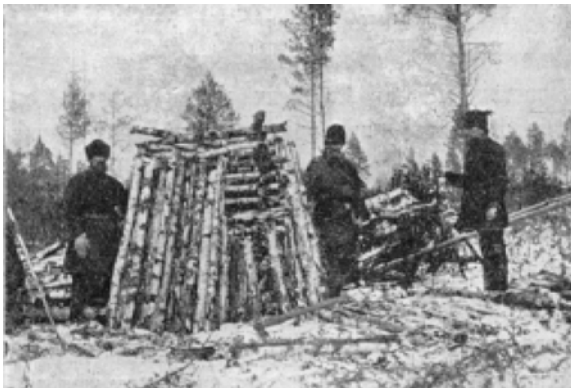
Ревдинский завод Закладка дров для кучного выжигания древесного угля Фото начала XX в.
