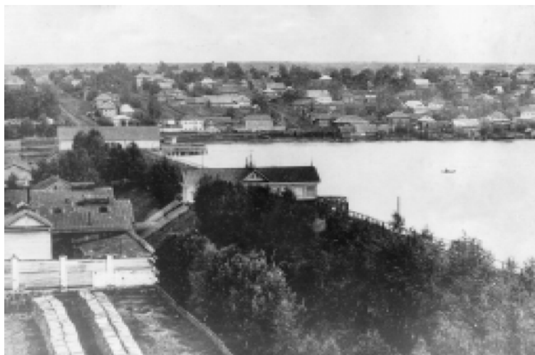
Очерский завод. Заводская плотина. Фото начала XX в.
