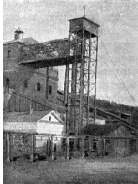
Симский завод. Подъемник на колошник доменной печи. Фото начала XX в.
