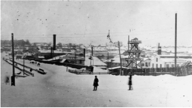
Первоуральский новотрубный завод. Панорама старотрубного завода. Фото 1930-х гг.
