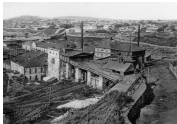
Невьянский завод. Корпуса доменных печей и колошниковый мост.
