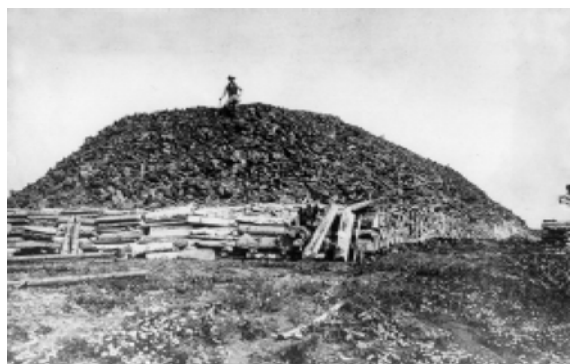
Кусинский завод. «Пожог» железной руды на Ахтенском руднике Фото начала XX в.
