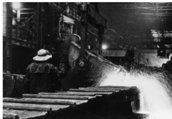
Южно-Уральский никелевый завод. Разлив автоклавной массы. Фото 1990-х гг.
