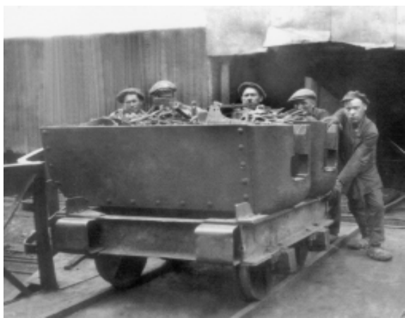
Златоустовский металлургический завод. Рабочие у шахты лифта при вывозе металлолома. Фото 1930-х гг.
