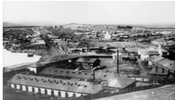
Черноисточинский завод. Фото начала XX в.
