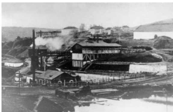
Кусье-Александровский завод. Плотина и доменный цех Фото начала XX в.
