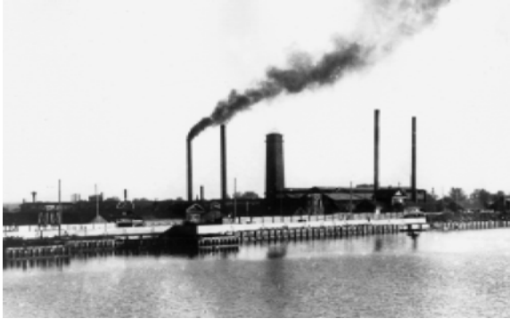
Чёрмозский завод. Фото начала XX в.
