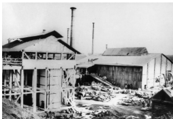
Нязе-Петровский завод. Доменный и мартеновский цеха. Фото конца XX в.
