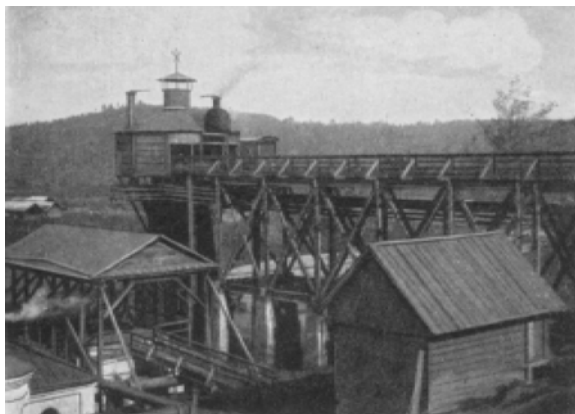
Инзерский завод. Доменная печь. Фото начала XX в.
