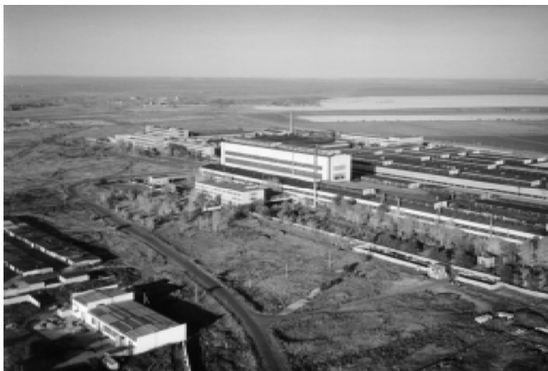
Гайский завод ОЦМ. Панорама завода. Фото 1990-х гг.
