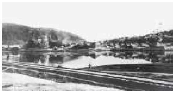
Златоустовский нижний завод. Вид заводского пруда. Фото начала XX в.
