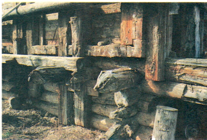
Фрагменты ряжевого основания ларя Fragments of a log-grating foundation of the salt box
