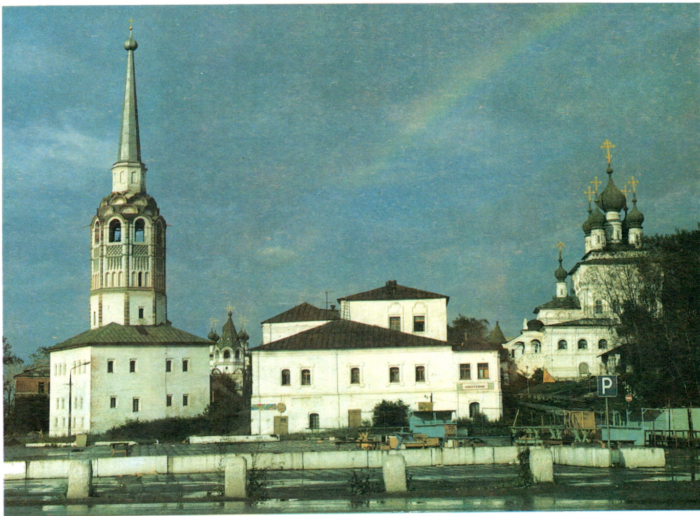
Центральный историко-архитектурный ансамбль Соликамска The central historical-architectural ensemble of Solikamsk
