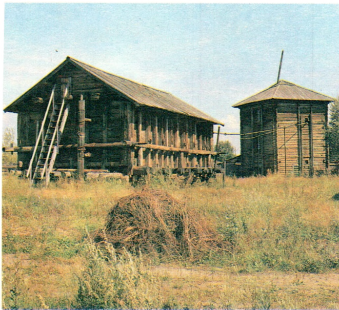
Соляной ларь и рассолоподъемная башня Salt box (lar) and brine-lifting tower
