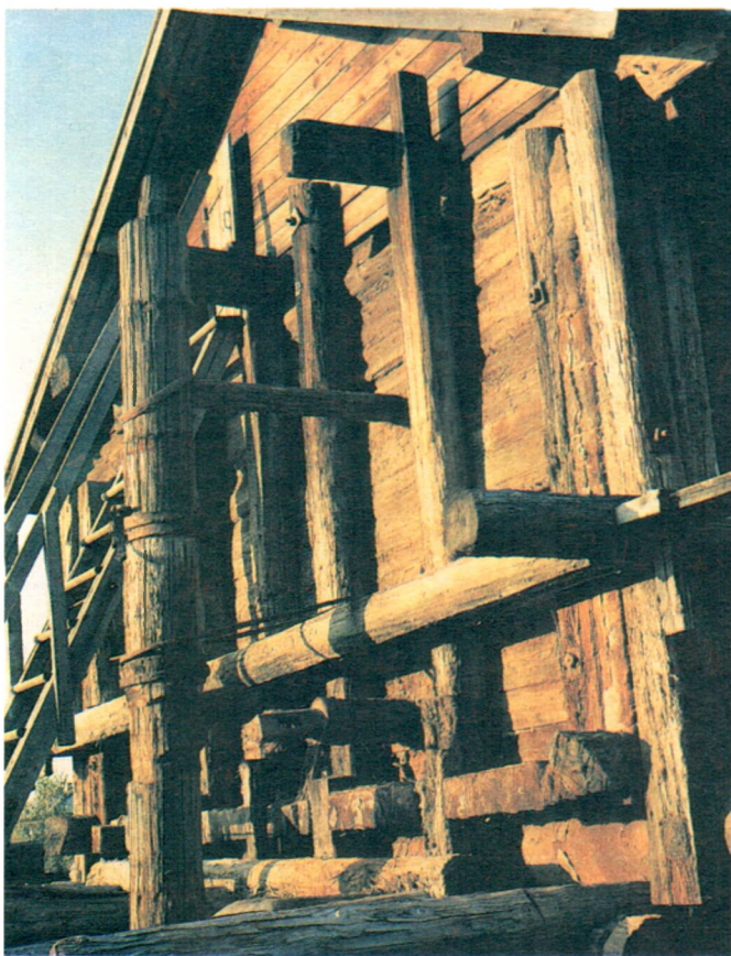
Деревянный рассолоотвод Wooden brine-drain of the salt box
