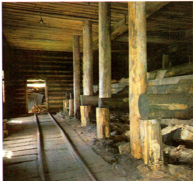
Вид варницы внутри Saltery interior
